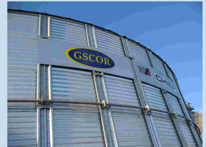
W-образное ребро жесткости, кольца для ветровой нагрузки и волнистая конструкция боковых стен зернохранилища
