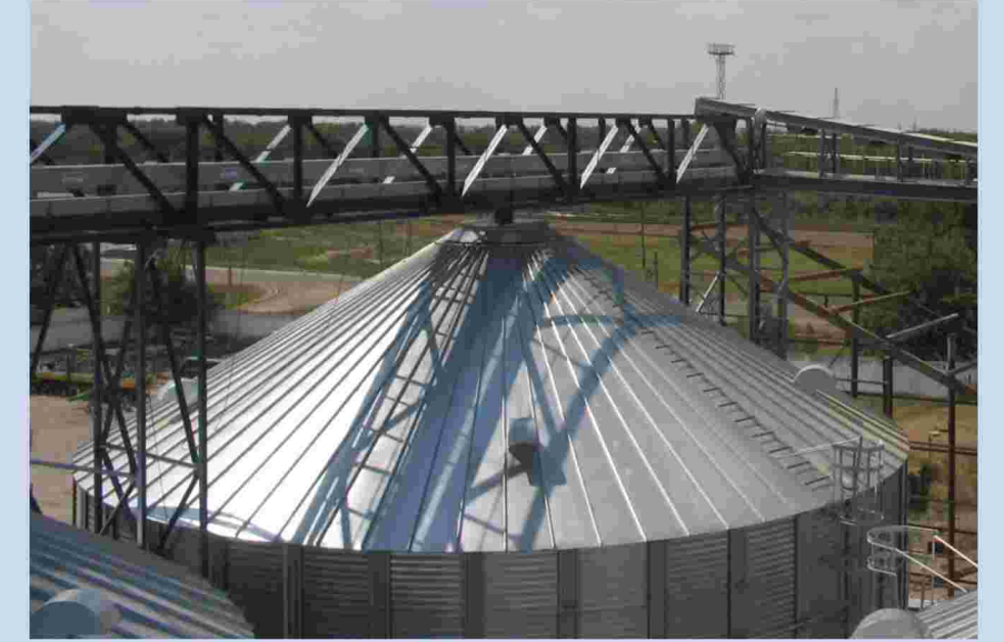
Конструкция крыши зернохранилища
