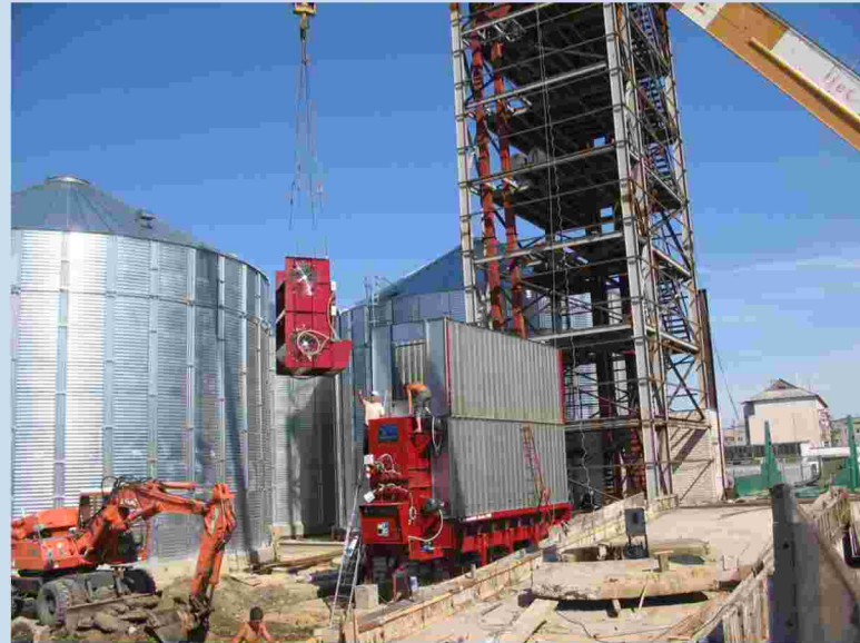
Монтаж зерносушилки
