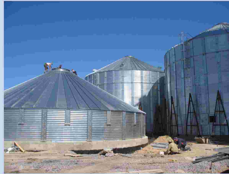
Монтаж емкостей зернохранилища
