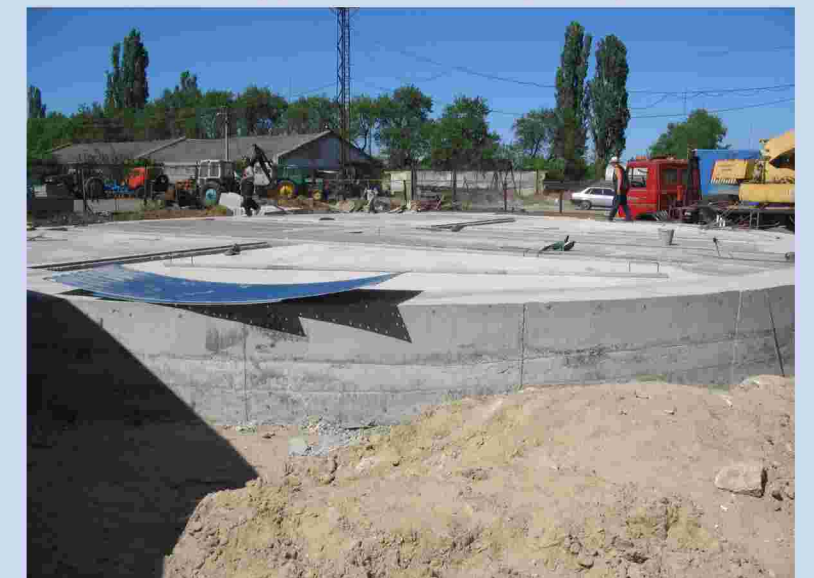
Подготовка фундамента зернохранилища
