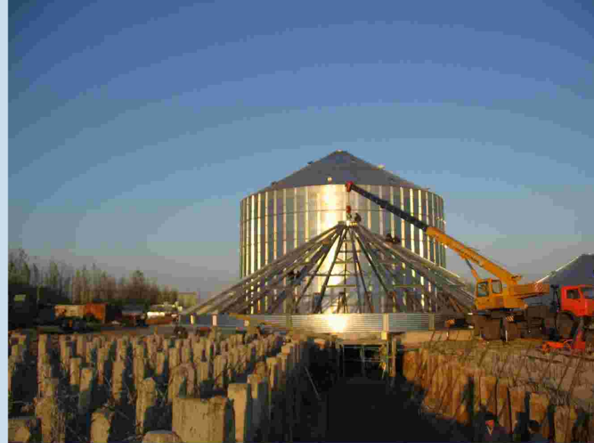
Монтаж емкостей зернохранилища
