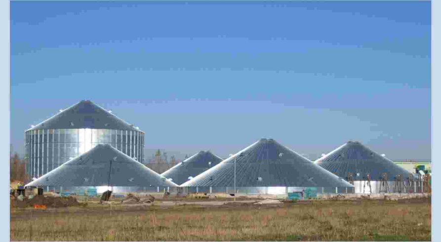
W-образное ребро жесткости, кольца для ветровой нагрузки и волнистая конструкция боковых стен зернохранилища
