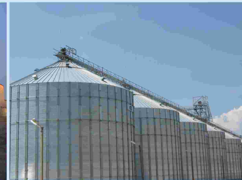
Зерновой склад емкостью 40 000 тонн в Херсонской области (Украина)
